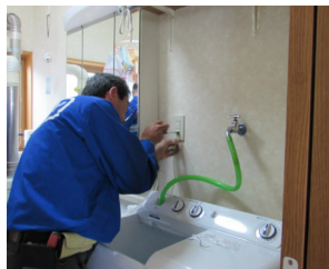
洗濯機の設置
