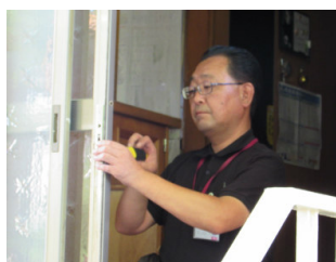
引違錠の取付
