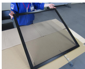
網戸の張替・設置
